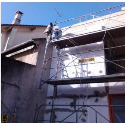
**Une isolation extérieure traitée avec le système complet StoTherm Classic** ici composé d'un isolant en polystyrène graphité, d'un mortier colle, d'un treillis d'armature en fibres de verre et d'un enduit de finition
