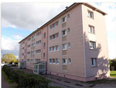
Avant les travaux de rénovation, la vêtue présentait une couleur rose uniforme sur l'ensemble des façades.
