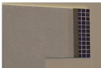
Exemple de ravalement technique d'une ancienne pâte de verre des années 70 en système d'imperméabilité de classe I3 : l'une des spécialités de Sto.
