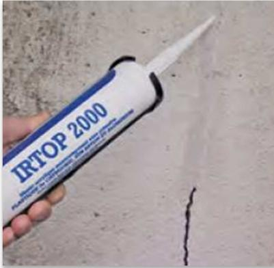
Traitement d'une fissure avec le mastic souple Irtop 2000 spécifique
