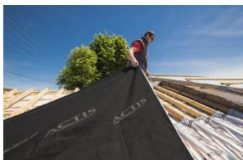
TRISO TOITURE est une solution d'isolation souple idéale pour la toiture par l'extérieur 3 en 1 qui assure à la fois l'isolation thermique hiver/été avec des performances élevées, l'isolation phonique et l'étanchéité à l'eau à l'air.
