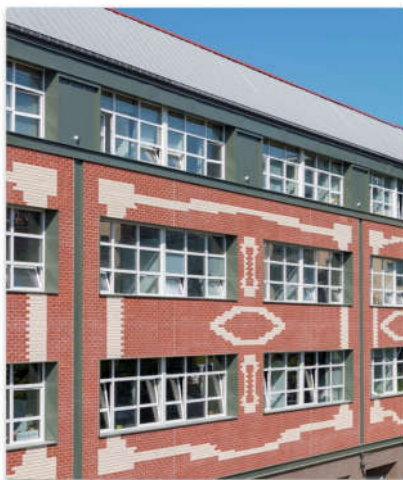
En juin 2019, après un an de travaux, le bâtiment a retrouvé son allure d'antan. Crédit photo : Manuel Panaget
