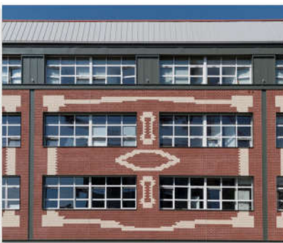
Le recouvrement feu est ici réalisé avec un dispositif invisible de l'extérieur en remplacement de la bavette acier débordante. Crédit photo : Manuel Panaget
