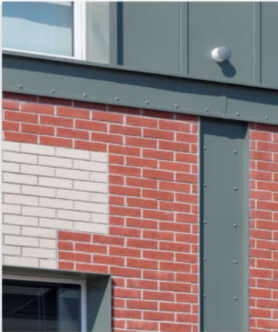
Dans les recouvrements viennent se loger des bandes d'aluminium laquées grises qui reconstituent l'aspect de la structure métallique d'origine. Elles sont ornées de cabochons en aluminium imitant les rivets style Eiffel. Crédit photo : Manuel Panaget
