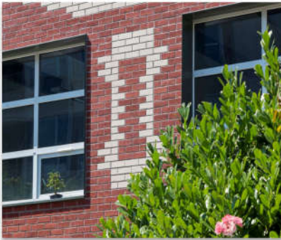
Le bardage StoVentec SCM avec finition en briquettes de terre cuite est apparu comme la solution la plus satisfaisante. Crédit photo : Manuel Panaget
