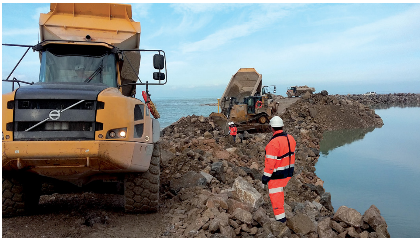
Réalisation d'une digue
