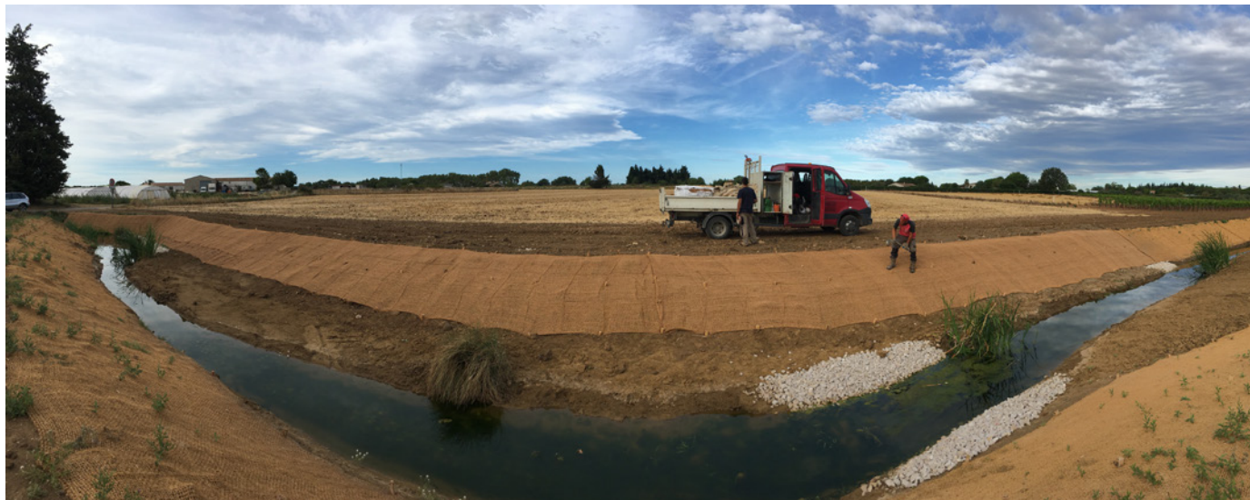
Renaturation des cours d'eau - Viredonne & Dardaillons
