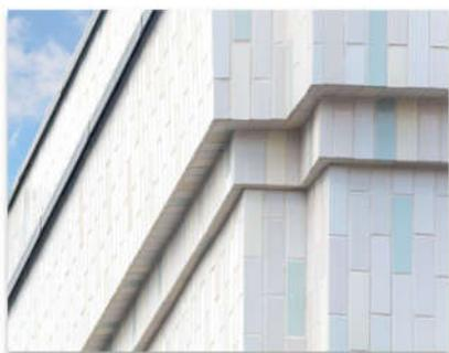
Sur les parties en relief ou biaisées telles que pilastres et bandeaux, les plaquettes sont scellées sur le support mis à nu, de façon traditionnelle.
