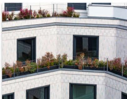
Les StoPanneau Ventec en billes de verre expansé avec liant époxy sont fixés sur le support via des profilés aluminium en oméga. Un primaire (StoPrim) est appliqué sur les plaques de bardage, puis recouvert d'un enduit de marouflage (StoLevell Uni) et d'un treillis d'armature en fibre de verre. Les plaquettes de terre cuite émaillée sont ensuite collées une à une à l'aide de mortier de collage avant d'être jointoyées.
