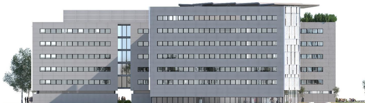
Façade côté Avenue du pont Pasteur © Chabanne
