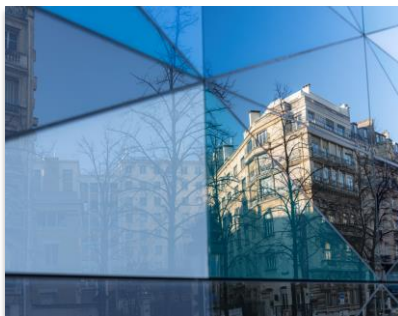
Cette fresque en verre émaillé suggère le reflet du contexte immédiat du mur avec un traitement dans la lignée des azulejos portugais. Crédit photo : Manuel Panaget
