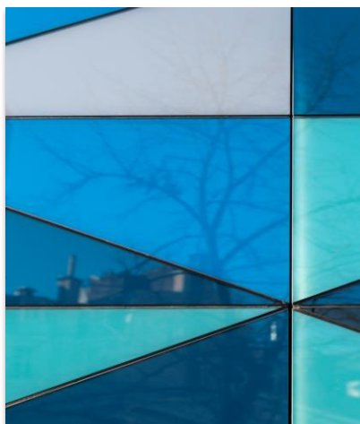
Les panneaux rectangulaires préfabriqués en usine réunissent six triangles de couleurs toujours différentes.
