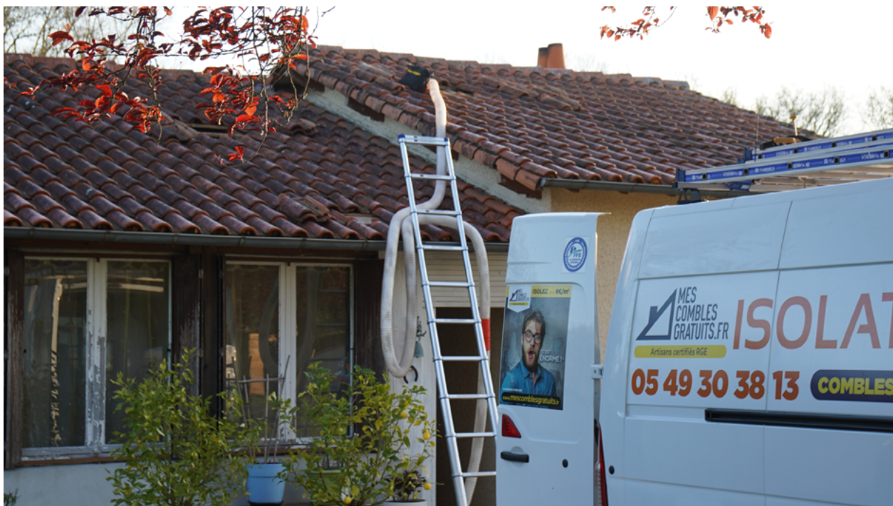
Chantier Hellio d'isolation des combles le 9 avril 2020 à Migné-Auxances (86) par le Groupe Vinet. Photo @Hellio
