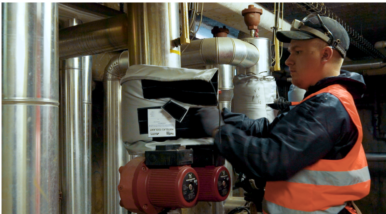
Travaux d'isolation des points singuliers - Photo © Hellio
