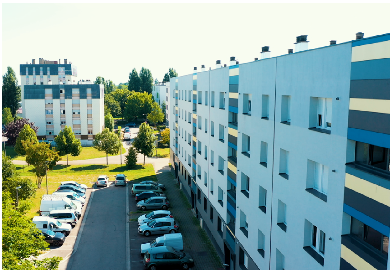
Logements des Sénardes à Troyes - Photo © Hellio
