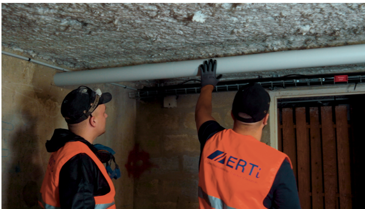
Travaux de calorifugeage - Photo © Hellio
