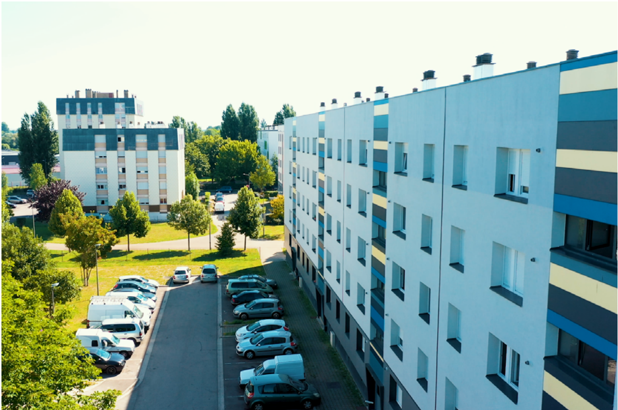
Logements des Sénardes à Troyes - Photo © Hellio
