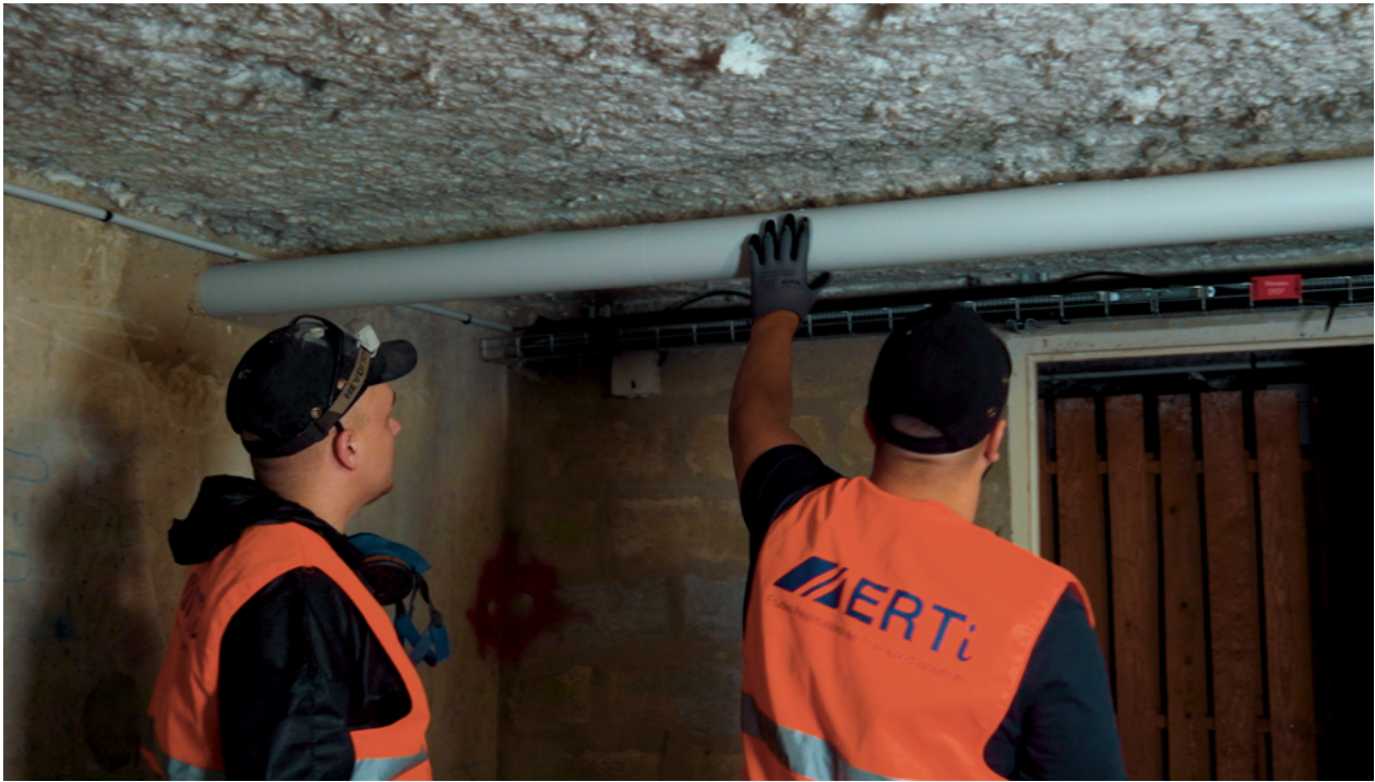
Travaux de calorifugeage - Photo © Hellio
