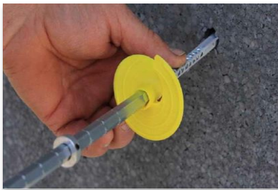
Un système de chevillage innovant pour une fixation de l'isolant rapide et sans effort
