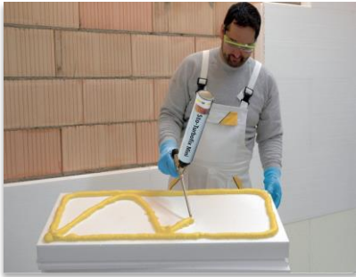
Un collage simple et rapide des panneaux PSE avec Sto-Turbofix Mini
