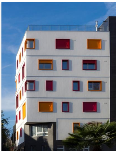
Logements / commerces à Montreuil (93) Solution Sto : StoVentec R Enduits sur COB en R+5 - Finition : Stolit K1 Architecte : Agence Meandre Maîtres d'ouvrage : CPA-CPS et ATHENAE CONSEIL Crédit photo : Sto
