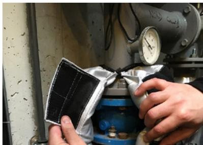
L'isolation des points singuliers consiste à isoler les vannes, robinets, réducteurs, compteurs présents en chaufferie et sous-station. Ces éléments sont aujourd'hui à nu, et provoquent une forte déperdition de chaleur dans les locaux techniques. L'isolation est réalisée en posant des matelas amovibles de laine minérale revêtus d'un tissu technique. Cette opération permet jusqu'à 15 % de déperditions en moins dans une chaufferie aux réseaux déjà calorifugés.
