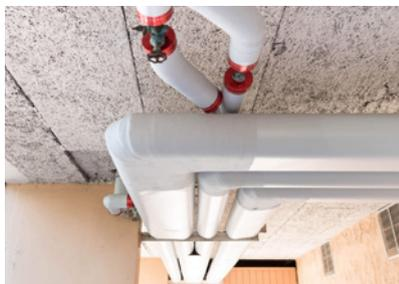
Le calorifugeage est l'isolation des réseaux de tuyaux de chauffage et d'eau chaude sanitaire dans les parties communes non chauffées. La remise à neuf et aux normes de l'ancien isolant (dépose, et pose d'un nouvel isolant de classe 3) est gratuite. Elle permet d'améliorer la salubrité des parties communes, ainsi que de diminuer les charges de la copropriété. Cette opération permet d'atteindre jusqu'à 15 % de réduction des charges de chauffage.
