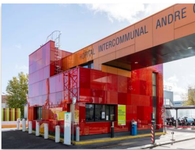
Poste de sécurité incendie et anti-malveillance CHI André Grégoire, Montreuil (93)
