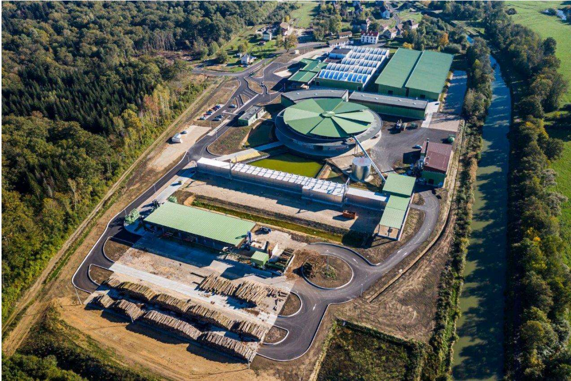
Ci-dessus, photo aérienne du site Bois-Factory 70
