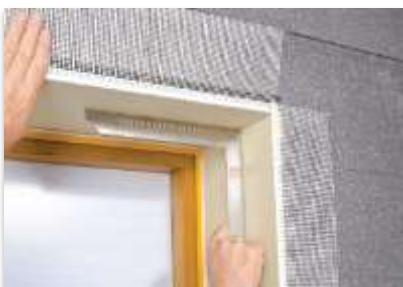
Le système 3 en 1 Sto Pronto facilite la pose des retours de tableaux.
