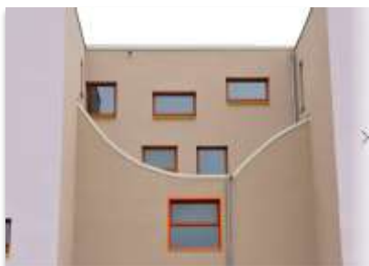
Construits à Bétheny (51) en 2009 à l'initiative du bailleur social Le Foyer Rémois, les logements sociaux « La Clairière » ont été le premier ensemble de ce type classé Passivhaus en France. L'ITE StoTherm Classic inclut ici l'isolant PSE graphité en très forte épaisseur (30 cm). Crédit photo : Sto
