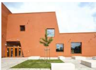
Ecole passive en Belgique Architecte : TEEMA architecten bvba, Brasschaat, BE Maître d'ouvrage : AG Real Estate COPID, Bruxelles, BE Système d'isolation de façade StoTherm Vario avec isolant PSE graphité, 30 cm Finitions : Briquettes StoBrick (deux variantes distinctes) Crédit photo : Sto
