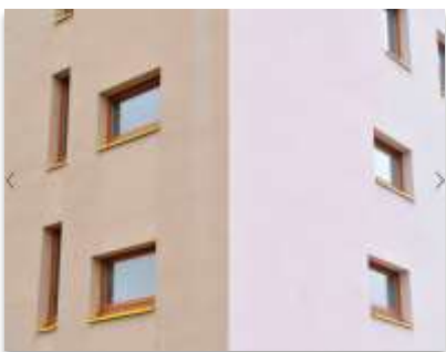
Construits à Bétheny (51) en 2009 à l'initiative du bailleur social Le Foyer Rémois, les logements sociaux « La Clairière » ont été le premier ensemble de ce type classé Passivhaus en France. L'ITE StoTherm Classic inclut ici l'isolant PSE graphité en très forte épaisseur (30 cm). Crédit photo : Sto
