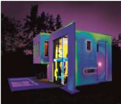
Maison passive, Klagenfurt (Autriche). Architectes : active-SUNCUBE, Klagenfurt La thermographie rend bien compte de l'efficacité de l'ITE : les zones bleues et violettes correspondent à un très faible coefficient de transmission.
