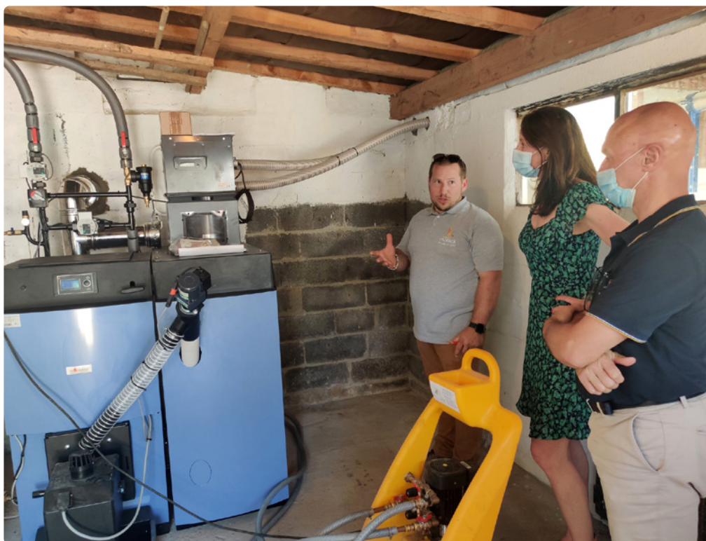
La société Matlex partenaire de Hellio a effectué le remplacement d'une chaudière fioul par une chaudière à granulés bois en présence de la députée dans la 6 ème circonscription du Nord, Charlotte Parmentier Lecocq, et du Maire de Landas, Jean-Louis Dauchy.
