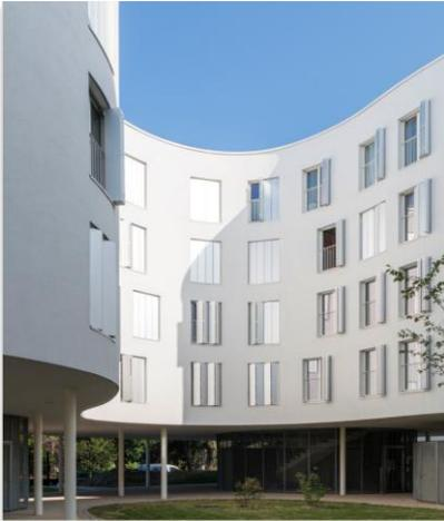
L'enduit de finition taloché à grain fin Stolit K1 blanc ivoire offre la surface lisse attendue par les architectes pour mettre en évidence la géométrie des bâtiments.
