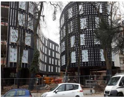
La sous-construction Sto est mise en œuvre en système mixte avec une ossature verticale métallique et une ossature horizontale cintrée en bois.
