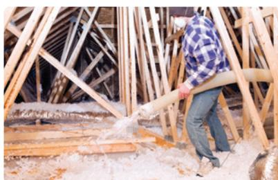
**L'isolation des combles** en copropriété est primordiale pour limiter les pertes de chaleur. En effet, les calories s'échappent en priorité par le toit d'un immeuble car la « chaleur monte ». La technique pratiquée pour ces travaux de rénovation énergétique est le soufflage. Concrètement, cela consiste à souffler l'isolant – de la laine minérale – sous forme de flocons dans les combles perdus des parties communes.
