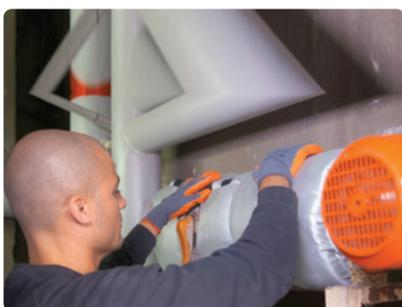
En complément du calorifugeage, **l'isolation des points singuliers** (vannes, pompes, compteurs...) permet de supprimer les ponts thermiques et ainsi diminuer la consommation énergétique dans les locaux techniques. Ces points sont recouverts de matelas amovibles de laine minérale, une technique simple et rapide.
