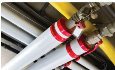
Le **calorifugeage** consiste à isoler des réseaux d'eau chaude sanitaire et de chauffage situés dans les caves et parkings d'un immeuble. Objectif : limiter le gaspillage d'énergie tout en maintenant la chaleur dans les appartements plutôt que dans les caves. Concrètement, pour isoler les canalisations, les artisans partenaires Hellio enrobent les tuyaux d'une gaine calorifuge en laine de roche, protégée par un tube en PVC lavable.
