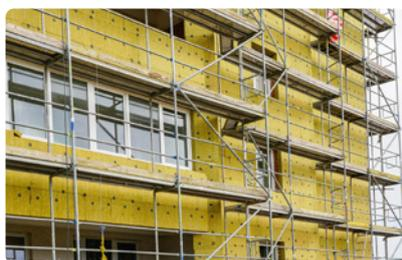
**L'isolation thermique des murs par l'extérieur (ITE)** possède de nombreux avantages : elle permet de réduire les déperditions thermiques, de limiter les ponts thermiques, d'améliorer le confort des occupants et d'assurer l'étanchéité des façades contre les infiltrations d'air. Dans le même temps, l'immeuble bénéficie d'un ravalement de façade et donc d'une revalorisation du patrimoine.
