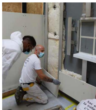
La formation « Chantier école ITE bardage ventilé »
