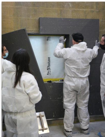
La formation « Chantier école ITE enduit mince sur isolant »
