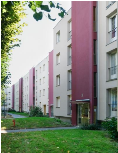
Résidence Le Galicie, Rennes (35) À Rennes, la résidence le Galicie vient d'achever des travaux d'isolation thermique. Photo : @Marc Knecht
