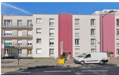
Résidence Le Galicie, Rennes (35) L'architecte Séverine Touchet a travaillé avec la coloriste de la Ville de Rennes à une présélection de gammes de couleurs afin de redonner vie à cette façade neutre et pâle. Photo : @Marc Knecht
