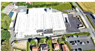
L'usine de production vendéenne de La Copechagnière s'étend sur 8 500 m 2 couverts
