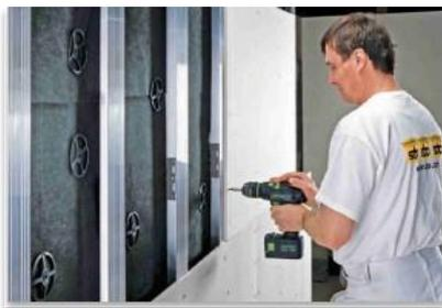
La combinaison efficace de la sous-construction inox / aluminium pour façades ventilées permet de réduire très efficacement les ponts thermiques ainsi que le temps de pose.
