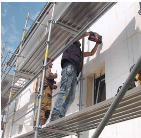
Mise en œuvre d'une isolation thermique par l'extérieur par Hellio et ISOPRO Nord Est à Taverny (95)
