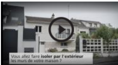
Une vidéo de 2 minutes pour comprendre le déroulement d'un chantier d'ITE avec les produits Sto
