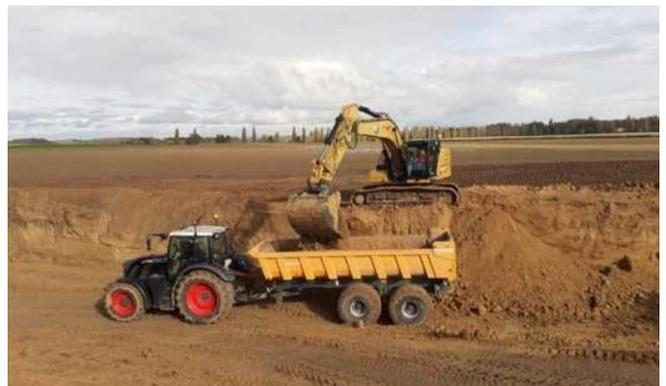
Afin de réduire les quantités de terres mises en stocks provisoires puis reprises pour mélange et mise en œuvre, Spie batignolles valérian a opéré un travail significatif pour valoriser un maximum de terres directement sur le site d'extraction. Il s'agit pour les équipes d'apporter des caractéristiques mécaniques élevées aux terres excavées par un traitement au ciment. Le chantier nécessitait le mélange de deux catégories de matériaux limoneux.
