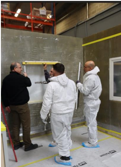
La formation « Chantier école ITE enduit mince »
