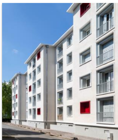
La résidence due la Saussaie à Thiais (94) APRÈS : Pour donner une image plus contemporaine au bâtiment, l'architecte propose de réaliser une ITE revêtue d'un enduit lisse beige clair. Les fenêtres sont soulignées par des cadres en tôle d'aluminium laqué plié de teinte grise ou, aléatoirement, de couleur rouge. Crédit photo : Manuel Panaget
