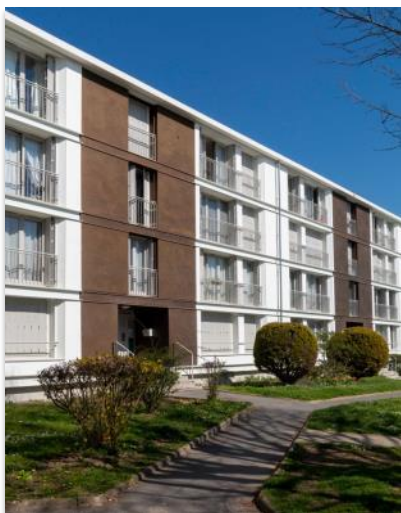
La résidence du Moulin Vert à Sannois (95) Pour mettre en œuvre cet enduit innovant à l'aspect béton, l'entreprise GCEB a bénéficié de l'accompagnement de Sto sur le chantier. Crédit photo : Manuel Panaget
