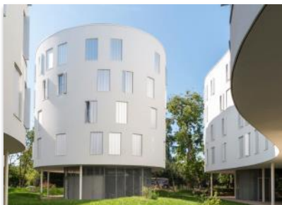
Afin d'insérer le projet dans son environnement, les architectes ont réparti les logements dans quatre bâtiments aux multiples courbes et aux toitures végétalisées, reposant sur des pilotis.
