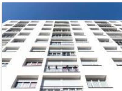
La résidence de la Vanne à Montrouge (92) Pour les façades, c'est l'isolation thermique par l'extérieur (ITE) qui s'impose comme la solution la plus efficace pour atteindre l'objectif ambitieux du label BBC Effinergie rénovation. Crédit photo : Manuel Panaget
