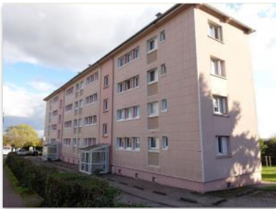
Avant les travaux de rénovation, la vêtue présentait une couleur rose uniforme sur l'ensemble des façades.
