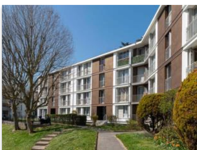
La résidence du Moulin Vert à Sannois (95) Avec ses 287 appartements, la résidence du Moulin Vert, à Sannois (Val d'Oise), est l'un des plus importants ensembles de logements du bailleur social francilien Immobilière du Moulin Vert (SAIMV). Crédit photo : Manuel Panaget
