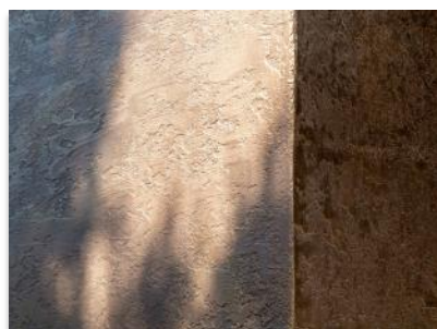
La résidence du Moulin Vert à Sannois (95) L'opération de pastillage consiste à déposer de façon aléatoire des petites quantités de Stolit Milano afin de recréer un relief. Crédit photo : Manuel Panaget
