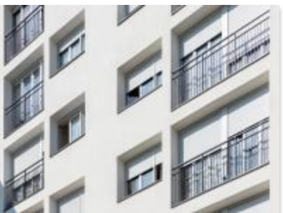
La résidence de la Vanne à Montrouge (92) Le maître d'œuvre choisit la sécurité en prescrivant sur l'ensemble de la façade la mise en œuvre d'un système d'isolation extérieure avec isolant incombustible constitué de panneaux de laine de roche. Crédit photo : Manuel Panaget
