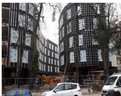
La sous-construction Sto est mise en œuvre en système mixte avec une ossature verticale métallique et une ossature horizontale cintrée en bois. Crédit photo : Manuel Panaget
