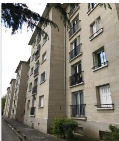
La résidence due la Saussaie à Thiais (94) AVANT : Construit dans les années 1960 en pierre naturelle, cet immeuble R+4 n'avait encore bénéficié d'aucune isolation des murs de façade. Crédit photo : Manuel Panaget
