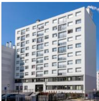
La résidence de la Vanne à Montrouge (92) de 9 étages a été construite au tournant de la décennie 1970. Crédit photo : Manuel Panaget
