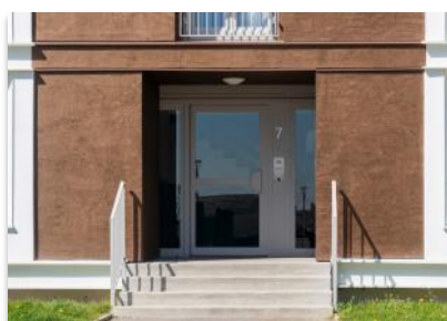
La résidence du Moulin Vert à Sannois (95) Pour casser l'image des barres des années 60 et mieux identifier les entrées, des failles verticales de couleur foncée au niveau des halls tranchent avec le blanc des parties courantes. Et pour ajouter du relief à ces murs blancs, chaque nez de plancher sera souligné par un profilé métallique horizontal de la même teinte que l'enduit. Crédit photo : Manuel Panaget
