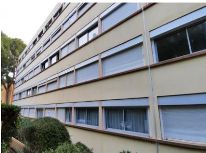
Résidence Méditerranée, Vallauris (06) (Avant) Autrefois enduite dans les tons ocre, cette copropriété de 150 logements a opté pour une ITE pour moderniser son image, tout en gagnant en confort et réduisant ses factures énergétiques. Photo : Sto
