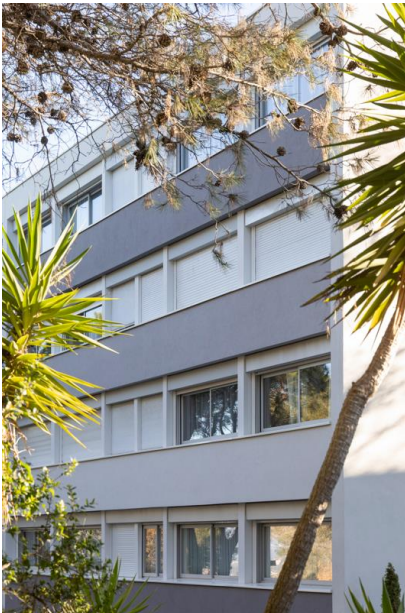
Résidence Méditerranée, Vallauris (06) L'isolation thermique par l'extérieur (ITE) concerne les façades nord des cinq bâtiments, ainsi que les murs pignons. Photo : Matthieu Colin
