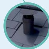
**Une sortie de toit VENTÉLIA** de Cheminées Pougoulat ou tout autre sortie de ventilation performante (tuile à douille).
