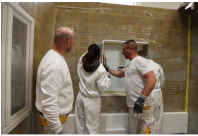
La formation « Chantier école ITE : enduit mince sur isolant »
