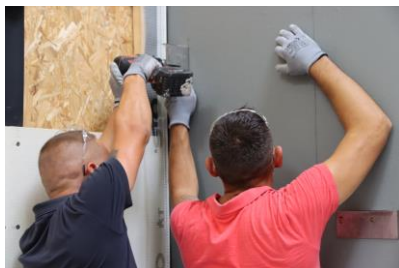
La formation « Chantier école : bardage ventilé »
