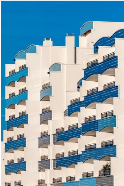
Résidence Le Président, Le Touquet (62) Construite en 1977 en front de mer par l'architecte boulonnais Pierre-André Dufétel, la résidence Le Président est une des résidences phares du Touquet. Photo : @Manuel Panaget
