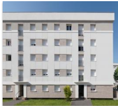
Réhabilitation de la résidence Le petit bois à Carrières sur Seine (78)
