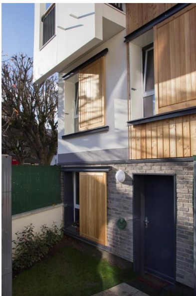
Petit collectif, Romainville (93) Solutions Sto : en parties basses StoVentec SCM plaquette de terre cuite sur chevrons bois, StoVentec R Enduits en R+1, 2 et 3. Maître d'ouvrage : OPH 93 Architecte : Benoît Bouvier, Paris. Photo : @Sto
