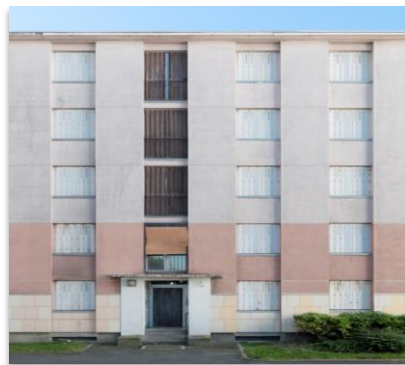
Résidence Le petit bois à Carrières sur Seine (78) avant réhabilitation
