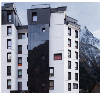
Rénovation de copropriété : résidence l'OUTA à Chamonix (74). StoVentec Glass Zone de sismicité moyenne (3) Pose sur bâtiment en béton Maître d'ouvrage : Nexity Architecte : Chevallier Architectes
