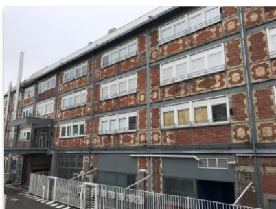
Typique de l'architecture industrielle du début du XX ème siècle, le bâtiment centenaire est resté des décennies sans entretien.
