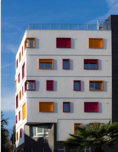
Logements / commerces à Montreuil (93) Solution Sto : StoVentec R Enduits sur COB en R+5 - Finition : Stolit K1 Architecte : Agence Meandre Maîtres d'ouvrage : CPA-CPS et ATHENAE CONSEIL Photo : @Sto
