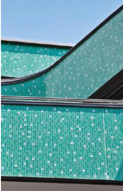
Immeuble résidentiel et commercial, Francfort (Allemagne)
