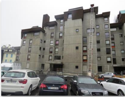
Résidence l'OUTA à Chamonix (74) avant rénovation
