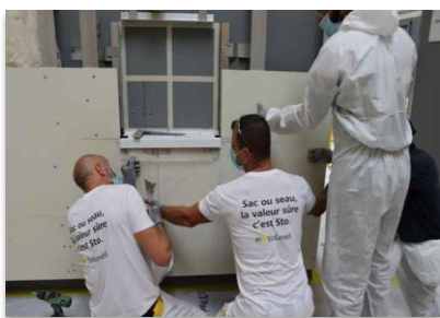
Formation « Chantier école bardage ventilé » dispensée au centre de formation et d'animation Sto à Bezons (95)
