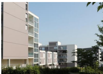
Logement social, avenue André Malraux, ZAC de Beauregard, Rennes (35). Maître d'œuvre : Atelier Fassot Architecture Photo : © Marc Knecht
