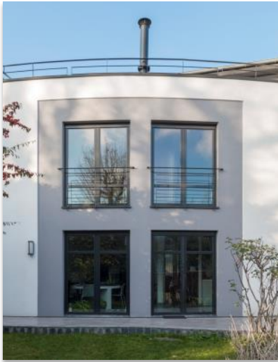
La façade côté jardin La finition de l'ensemble de la maison a été réalisée à l'aide d'un enduit très lisse taloché à l'éponge qui a ensuite été revêtu d'une peinture à l'aspect velouté.
