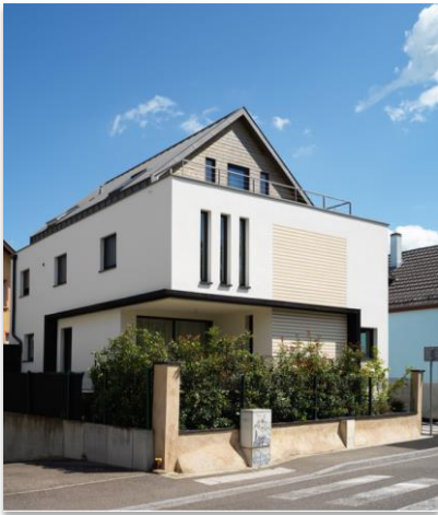
Quartier résidentiel de la Robertsau, Strasbourg (67) Construite dans les années 1950, cette maison ancienne du quartier résidentiel de la Robertsau a gagné en volume et en confort après restructuration et agrandissement. Crédit photo : Siméon Levailant
