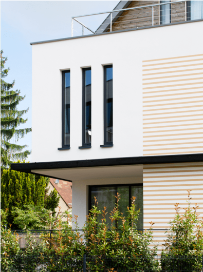
Exemple d'une rénovation réalisée avec l'enduit autonettoyant StoLotusan® et la peinture StoColor Lotusan® pour les lignes horizontales.
