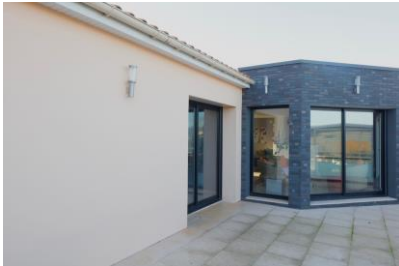
Maison individuelle (49) Solution Sto : StoTherm Vario 1 avec enduit de finition feutré StoSilco MP et StoBriquelette de parement gris flammé
