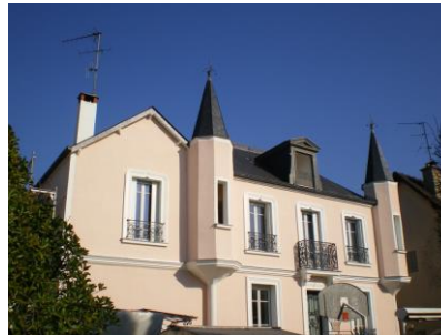
Pavillon de style atypique, La Varenne-St-Hilaire (94) Rénovation d'une ITE dégradée avec mise en place de modénatures StoDéco Profil réalisées sur mesure
