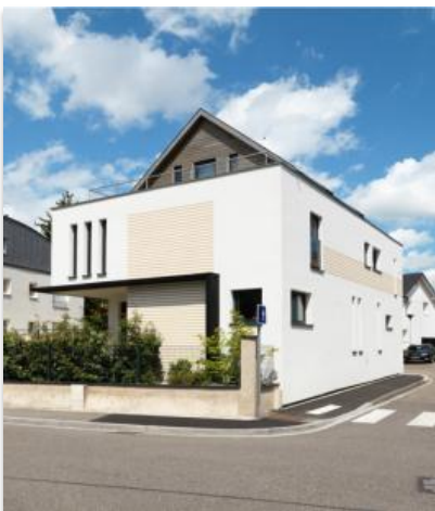
Quartier résidentiel de la Robertsau, Strasbourg (67) Située sur un terrain exigu, à l'angle de deux rues, la maison dispose d'un espace limité pour une ITE. Cette contrainte d'épaisseur conduit à choisir un isolant très performant : le Sto-Panneau Isolant Top31 en PSE gris. Crédit photo : Siméon Levailant
