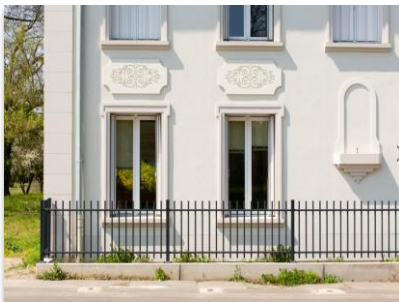
Système ITE StoTherm Vario, finition Stolit K1,5. Encadrements et appuis de fenêtre StoDeco sur mesure.
