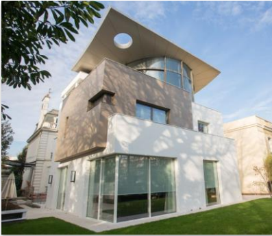
Pavillon à Boulogne Billancourt (92) Système StoTherm Classic finition Stolit Milano aspect marmorino métallisé.
