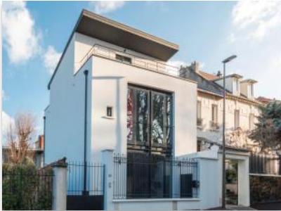
Une maison individuelle de la banlieue parisienne rénovée en ITE pour assurer le confort thermique et unifier la façade
