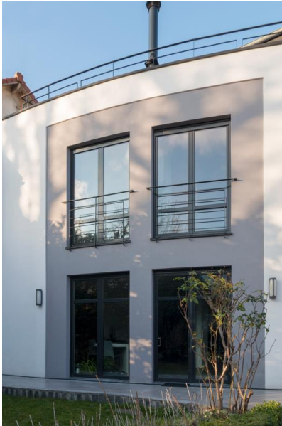
Maison individuelle, Suresnes (92) Solution Sto : StoTherm Classic avec enduit de finition StoNivellit et peinture StoColor Silco blanc (+ teintes grises X-black)
