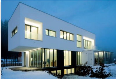
Maison individuelle (Autriche) Architecte : Di Gerhard Kopeinig Solution Sto : StoTherm Classic, finition StoLotusan.
