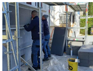
Le chantier se trouvant à l'extérieur, les occupants peuvent continuer à vivre normalement pendant toute la durée des travaux, et la surface habitable est préservée.
