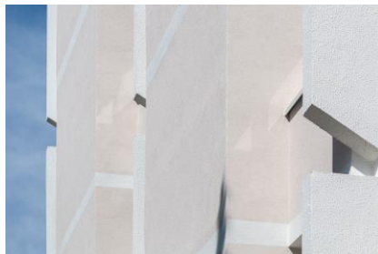
Résidence Les Primevères, Taverny (95) En parties courantes, l'enduit de finition utilisée est StoLotusan®, un produit haut de gamme qui intègre la technologie Lotus-Effect® avec une fonction autonettoyante. Photo : Manuel Panaget
