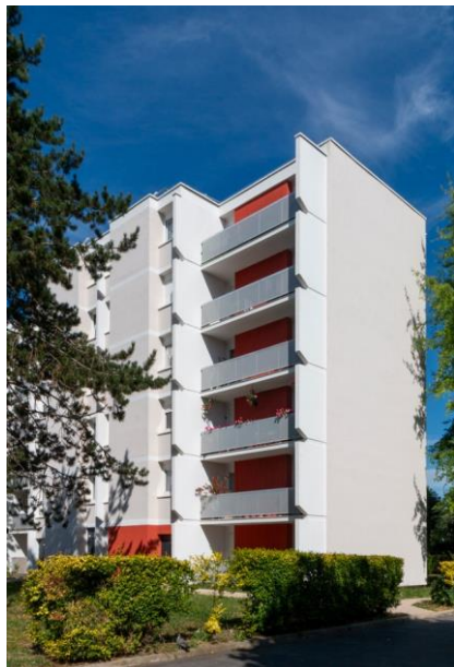
Résidence Les Primevères, Taverny (95) Plusieurs matériaux ou équipements déposés au démarrage du chantier ont pu, après remise à neuf et le cas échéant après rénovation, être remis en œuvre dans la résidence, comme les balcons. Photo : Manuel Panaget
