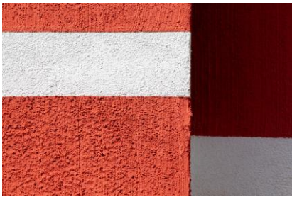
Résidence Les Primevères, Taverny (95) Utilisation de l'enduit modelable Stolit Effect dans un rouge soutenu, et avec un effet de balayage, pour obtenir une matérialité proche de la terre cuite. Photo : Manuel Panaget
