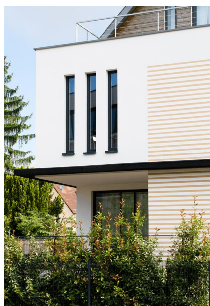
Dans le cadre d'une remise en peinture, certains revêtements de façade sont à privilégier. Exemple ici d'une rénovation réalisée avec l'enduit autonettoyant StoLotusan® et la peinture StoColor Lotusan® pour les lignes horizontales. Crédit photo : Simeon Levaillant
