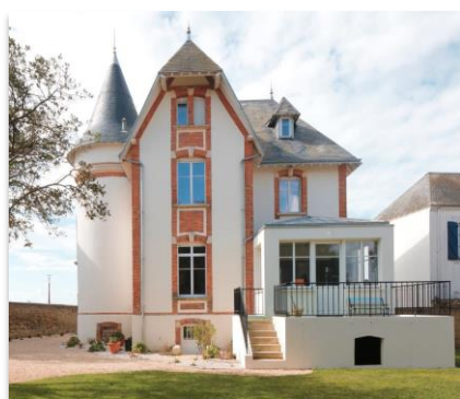
Maison ancienne rénovée avec la peinture minérale StoColor Solical, sans protection de film biocide.
