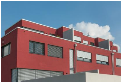
Grâce à la technologie X-Black, les teintes plus soutenues sont permises, en toute conformité avec la réglementation. Photo © Sto
