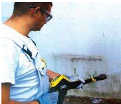
Travaux de décontamination
