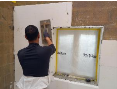
La formation « Chantier école ITE : enduit mince sur isolant »
