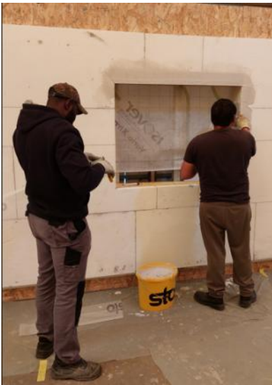
Session de formation « Chantier école ITE sur enduit mince » dispensée aux apprenants de l'école de la rénovation énergétique (éRE).
