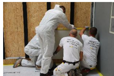
La formation « Chantier école : bardage ventilé »
