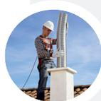
Flexible en inox à paroi intérieure lisse, STARFLEX+ est constitué d'une double peau d'épaisseur 2 x 0,10 m et permet le tubage des boisseaux traditionnels dévovés. Il assure une étanchéité parfaite et s'adapte à toutes les configurations existantes grâce à ses nombreux diamètres.
