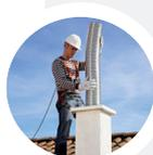
Conduit flexible en Inox à paroi intérieure lisse, STARFLEX+ est constitué d'une double peau d'épaisseur 2x0.10 et permet le tubage des conduits traditionnels dévovés. Il assure une étanchéité parfaite et s'adapte à toutes les configurations existantes grâce à ses nombreux diamètres.
