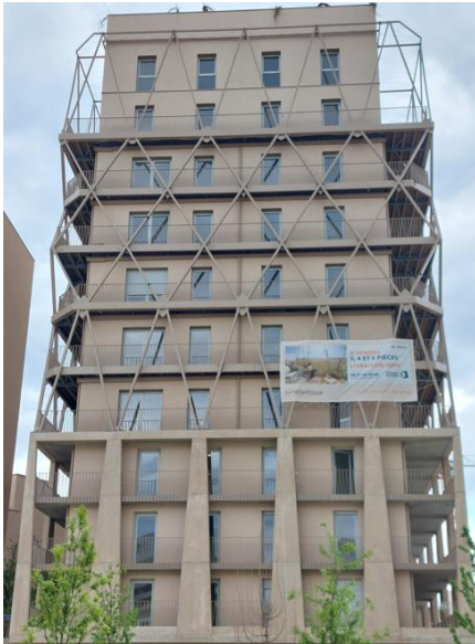
Les plaques StoVentec d'une dimension de 3,05 mètres ont permis de couvrir toute la hauteur de chaque étage en une seule fois. Crédit photo : Sto
