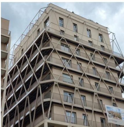
Les façades enduites supportées par une résille métallique porteuse, à l'assemblage en « X » qui reprend l'esthétique des poutrelles métalliques de l'architecture industrielle ayant existée sur le site. Crédit photo : Sto
