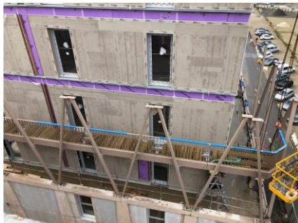
La gestion des fractionnements entre les FOB au cœur des enjeux pour le service technique Sto. Crédit photo : Pyrénées Charpentes
