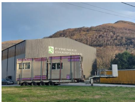
« Les murs à ossature bois sortent de nos ateliers avec le maximum d'éléments possible pour réduire notre temps de travail sur chantier. » Crédit photo : Pyrénées Charpentes
