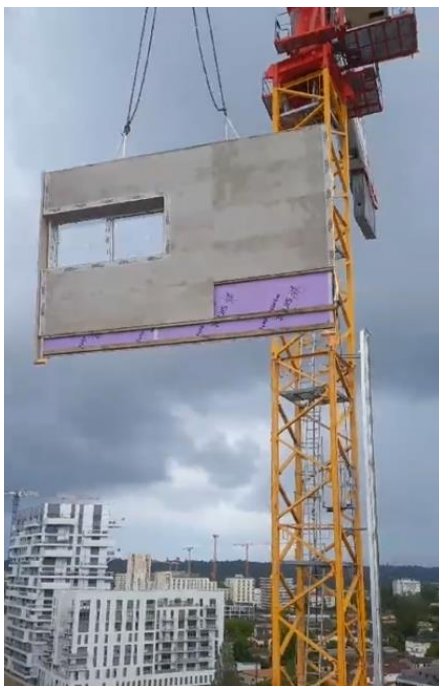
Mise en place des panneaux à l'aide d'une grue à tour. Crédit photo : Pyrénées Charpentes
