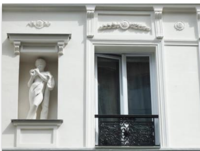
Immeuble rue de Montmartre, Paris (75) Encadrements de fenêtre réalisés en StoDeco
