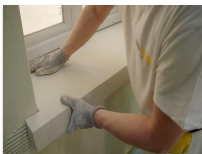
Mise en œuvre d'un appui de fenêtre
