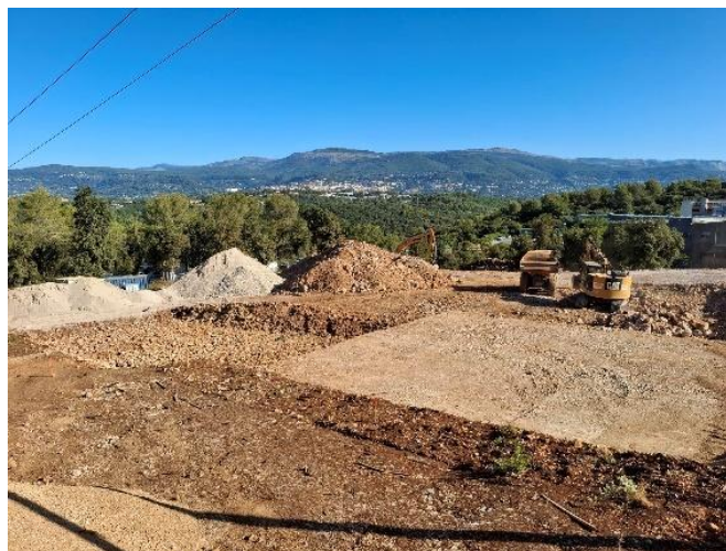
Travaux de terrassement et de VRD pour la création d'un village d'entreprises à Mouans Sartoux (06) pour la CCI Nice Côte d'Azur.
