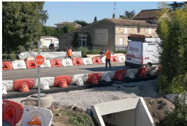
Déconstruction et reconstruction du Pont de Carré à Libourne (33) pour le Département de la Gironde.
