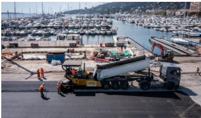
Requalification des infrastructures du site du chantier naval Golfe-Juan à Vallauris (06)
