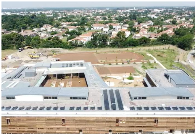
Collège Paleficat, Toulouse pour le CD31 Réalisation des aménagements extérieurs : terrassements, voiries, sols et espaces verts. Crédit photo : DANS LE CHAMP
