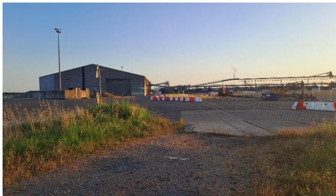
Création d'une plateforme multimodale à Bassens (33) pour le Grand Port Maritime de Bordeaux. Crédit photo : Spie batignolles
