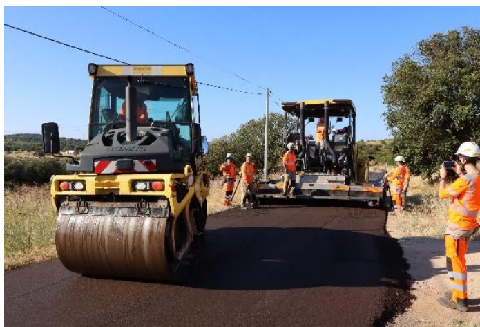
Chantier test pour le CD34 sur la RD 114. Mise en œuvre d'un enrobé de la gamme Kanopée formulé avec un liant biosourcé d'origine végétale.
