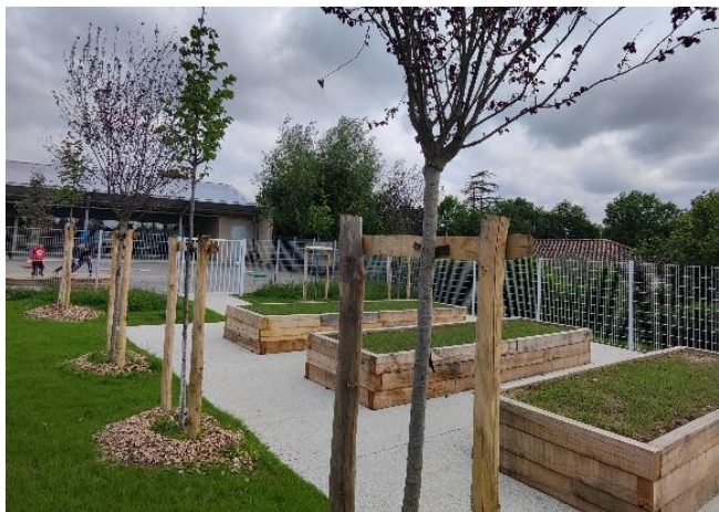
Restructuration de l'école élémentaire Pelleport avec création d'une cour Oasis pour la mairie du village. Crédit photo : Spie batignolles
