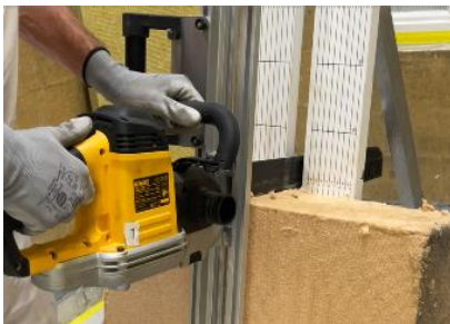
Découpe d'un panneau en fibre de bois avec la Sto-Scie
