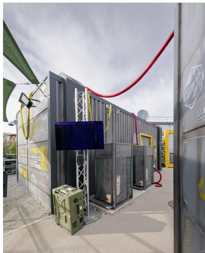
Dans le second bâtiment, qui n'abrite que des installations électriques, six unités gainables installées en plafond apparent fonctionnent à l'aide de trois VRV-5 2 tubes de référence RXYA16A (taille 16) et sont pilotées par 2 télécommande Madoka.
