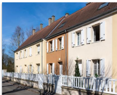
Chantier OPAC60 à Pont-Sainte-Maxence dans l'Oise avec le système StoTherm AimS® sur fibre de bois Crédit photo : Manuel Panaget
